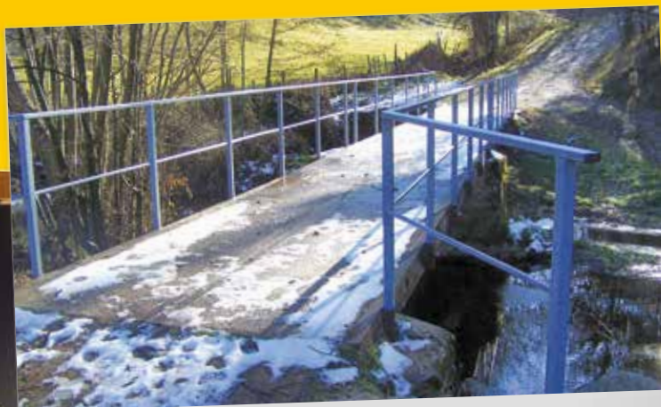
De nouvelles barrières pour le pont sur la Sumène, côté station, à Fay.
